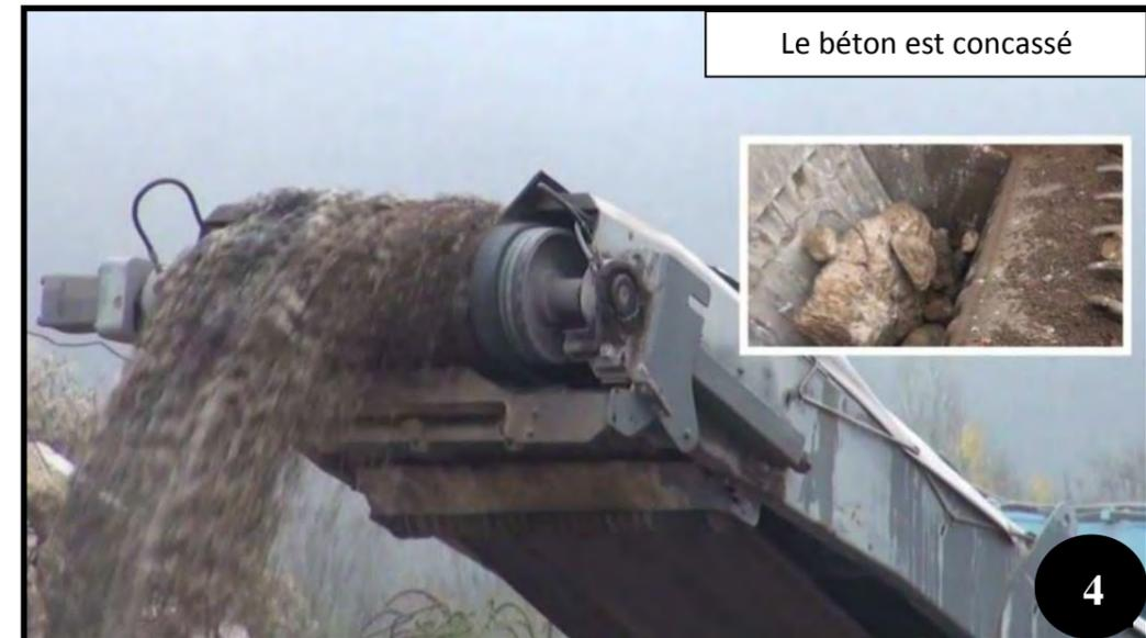
Photographie 30: Concassage du béton des fondations
