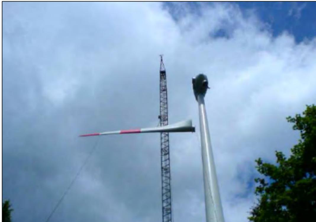
**Photographie 35: Opération de levage d'une pale sur un site éolien en forêt**
