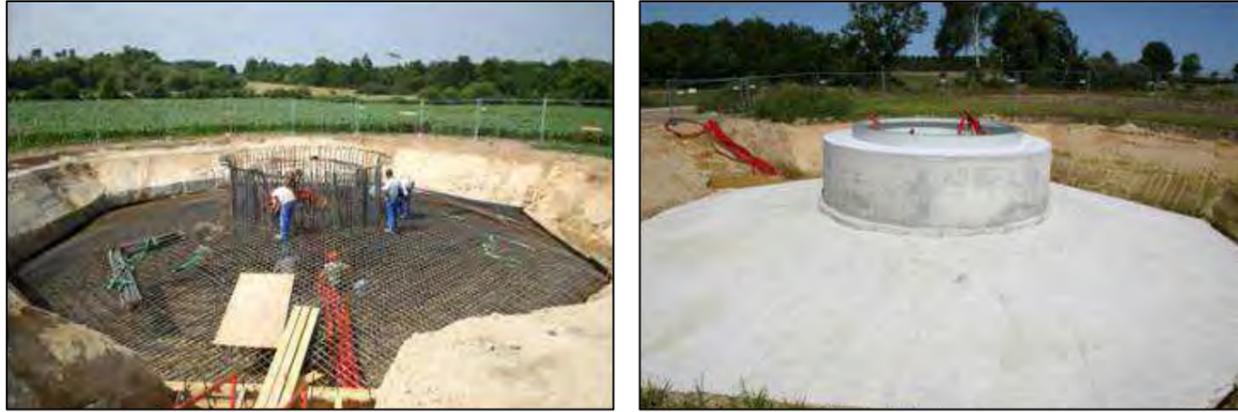
**Photographies 24 et 25 : Armature et fondation sur un parc éolien développé par IEL**
