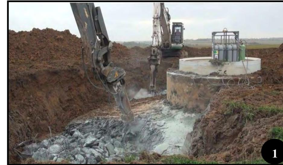
**Photographie 27: Destruction de la fondation par brise roche hydraulique**
