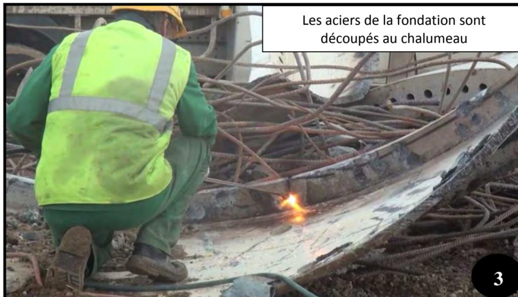
Photographie 29 : Tri et découpage au chalumeau d'acier
